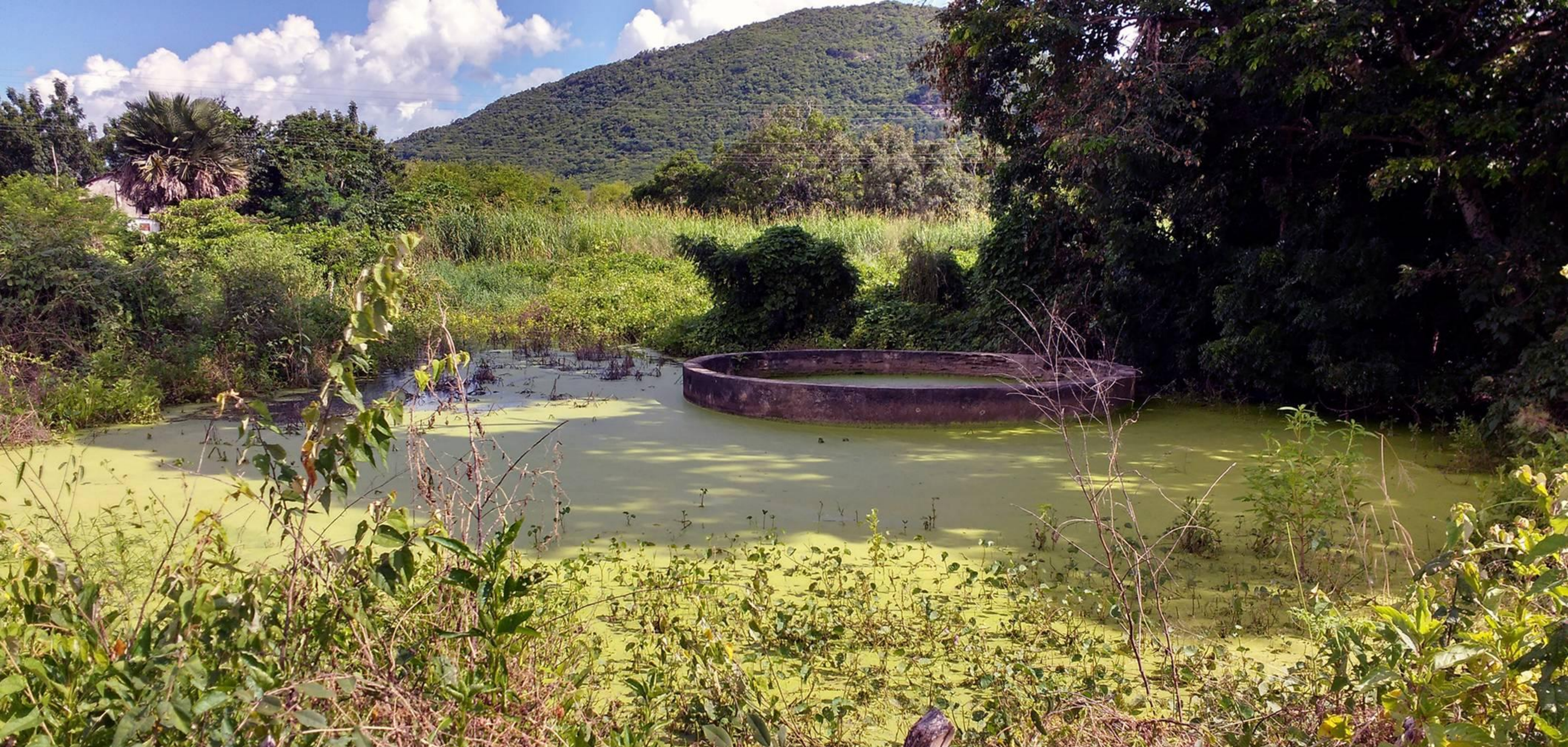
Poço amazonas com 4m de boca..
