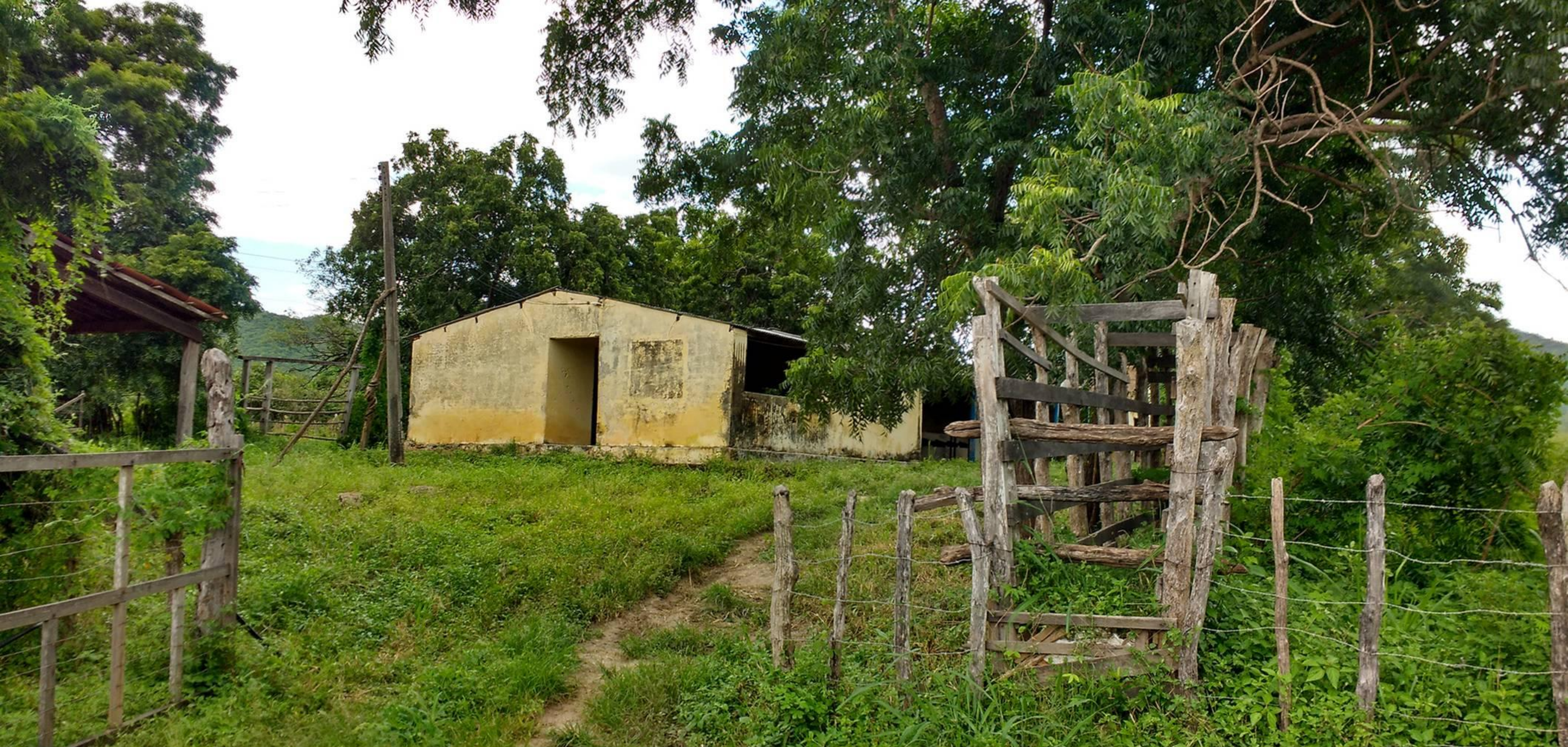
Galpão para máquinas , depósitos e contentor para bovinos .
